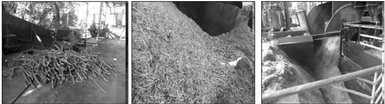
Figura 2. Astilladora fija, biomasa de marabú en forma de astilla y transporte de la biomasa hasta las calderas.
